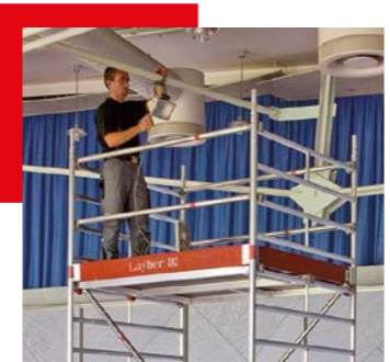
Seitenschutz nach DIN EN 1004
