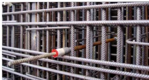
Das Stahlrohr sichert bei großen Bauteilstärken das Entfernen des Ankerstabs
