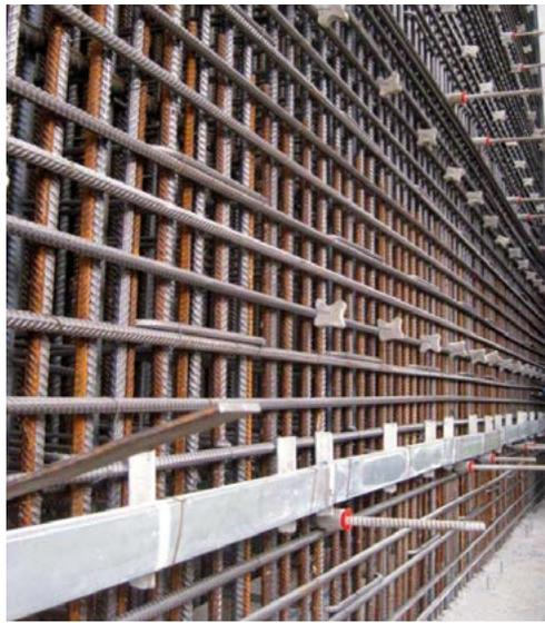
Rübox Bewehrungsanschlüssen in Wand neben Faserbeton-Einzelabstandhalter und Mauerstärken
