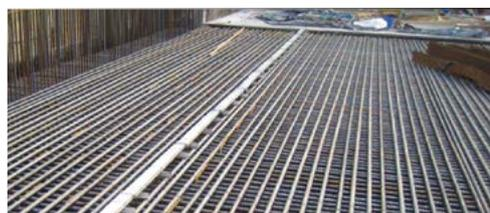
Rübox Bewehrungsanschlüssen in Bodenplatte
