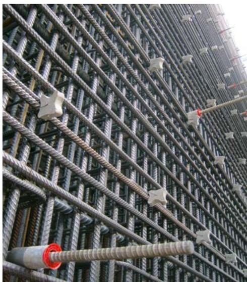
Faserbeton-Abstandhalter und eine Spannstelle mit eingesetztem Ankerstab am linken unten Bildrand
