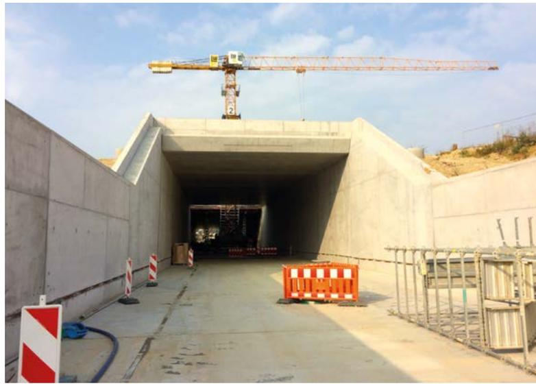
Der fertig betonierte Tunnel: Links und rechts an Wand und Boden lassen sich die Abdeckungen der Bewehrungsanschlussboxen als dunkle Streifen erkennen
