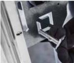
Antrittsstufe einhängen und durch Einsetzen der zwei Sicherungsstecker sichern.
